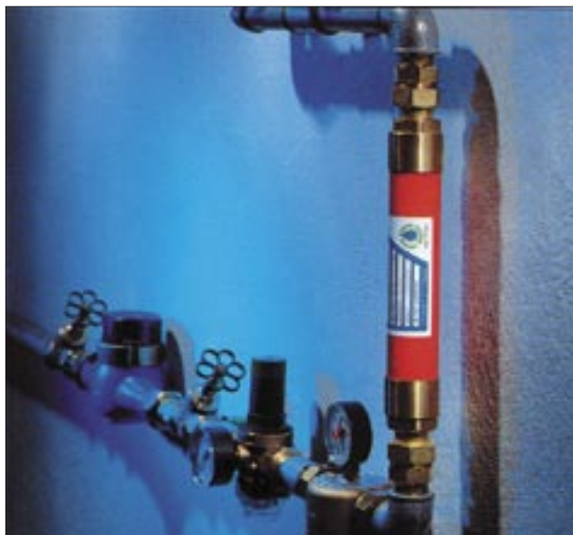
Den magnetiske vandbehandler monteres enkelt på koldt vandstilgangen efter vandmåleren
