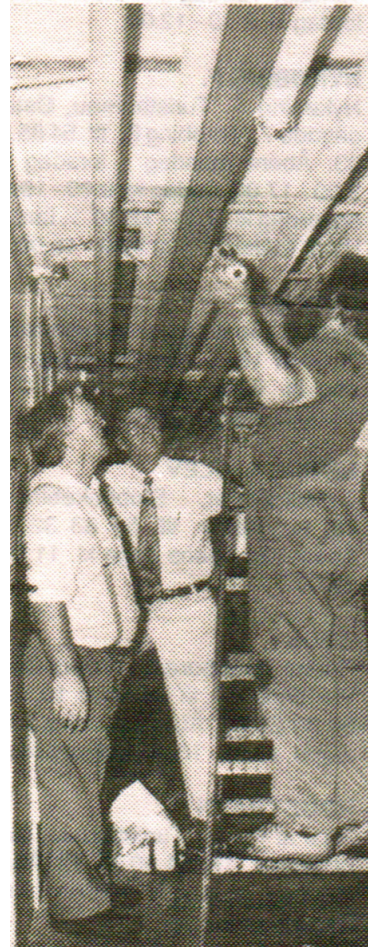
— Det var med spænding, man skiftede et stykke af rørene, for at se hvordan Solvin-anlægget havde virket i det godt tilkalkede rør.
